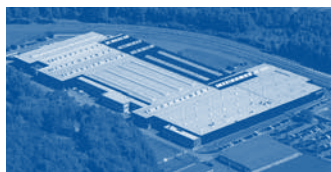
Hörmann KG Eckelhausen, Allemagne
